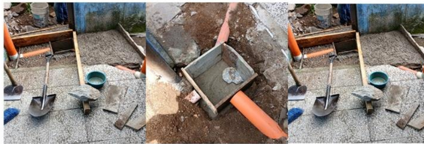
REPARACIÓN DRENAJE DE LA ESCUELA BARRIO CHOCRUZ
