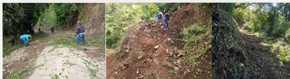
MANTENIMIENTO DE CAMINO RUTA CABECERA MUNICIPAL A CASERÍO EL PORVENIR CHIPOP
