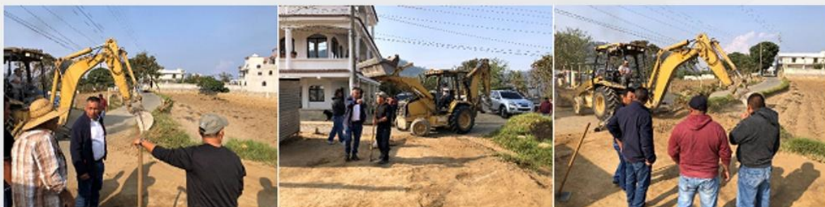
APERTURA DE CAMINO CALLE PRINCIPAL A PILA PÚBLICA CACERÍO PORVENIR CHIPOP
