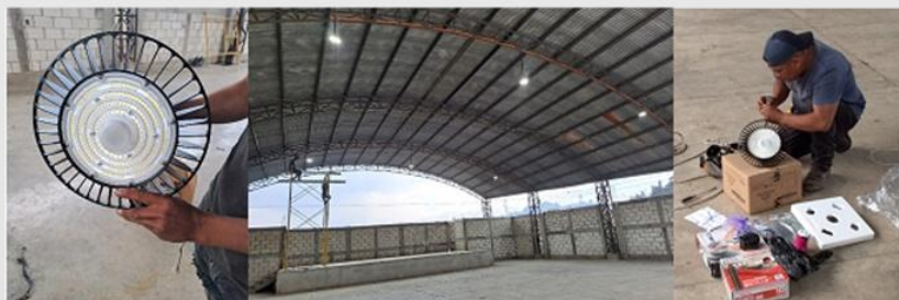
RESTAURACIÓN DE LÁMPARAS EN EL TECHADO DEL SALÓN COMUNAL DE LA ALDEA XEQUISTEL
