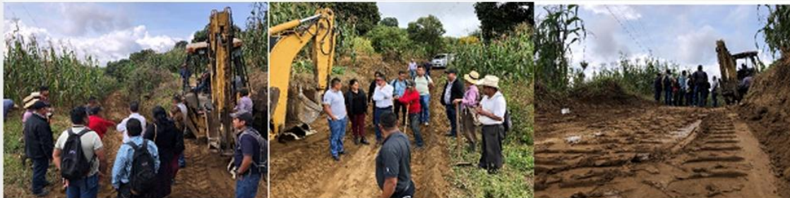
RECAPEO DE CAMINO EN EL SECTOR CHOJOLÓN CASERÍO SAN JOSÉ XIQUINABAJ
