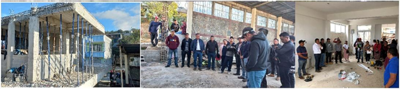
SUPERVISIÓN DE LA CONSTRUCCIÓN ESCUELA ALDEA AGUA ESCONDIDA
