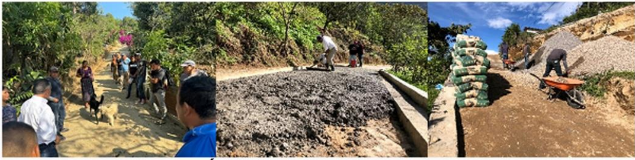
PAVIMENTACIÓN SECTOR #10 ALDEA AGUA ESCONDIDA
