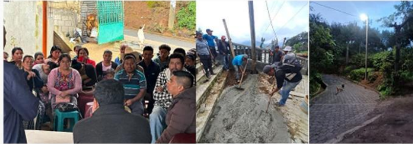
AMPLIACIÓN ALUMBRADO PÚBLICO SECTOR #8 ALDEA AGUA ESCONDIDA
