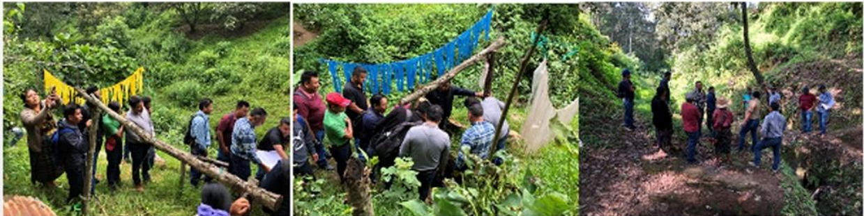
AVANCE DE PROYECTO NUEVO NACIMIENTO DE AGUA POTABLE CABECERA MUNICIPAL
