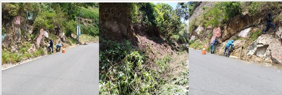
MANTENIMIENTO DE CAMINO RUTA CABECERA MUNICIPAL A PANAJACHEL
