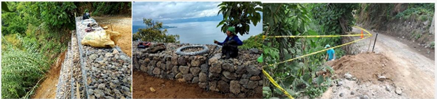
CONSTRUCCIÓN MURO DE GAVIONES ALDEA AGUA ESCONDIDA RUTA A CABECERA MUNICIPAL
