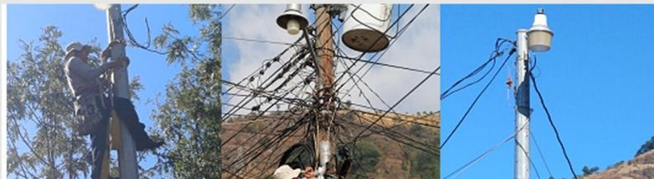
MANTENIMIENTO Y REPARACIÓN CABECERA MUNICIPAL
