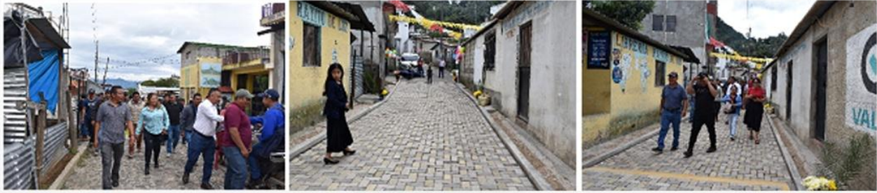
ENTREGA DE PROYECTO "MEJORAMIENTO DEL CAMINO RURAL EN LA CALLE PRINCIPAL DEL CANTÓN TZAMPETEY"
