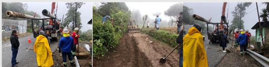
HABILITACIÓN DE ACCESOS POR MOTIVOS DE TEMPORADA DE LLUVIAS ÁREA RURAL
