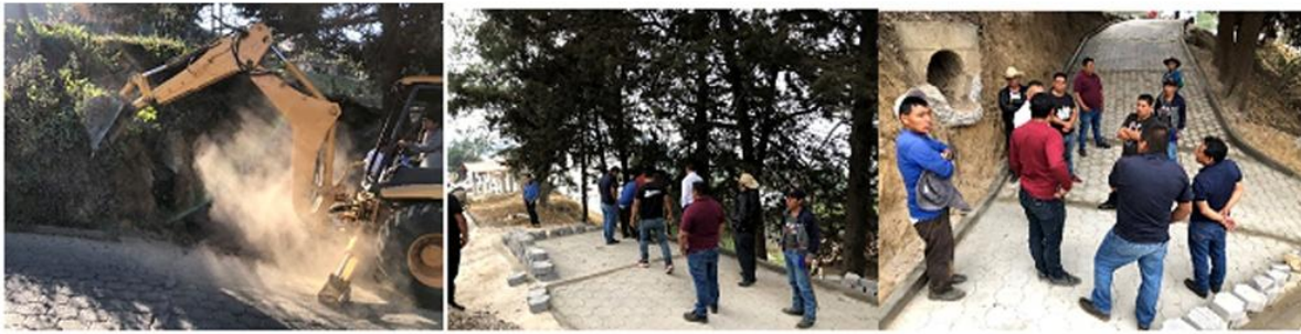
ADOQUINAMIENTO VIA ALTERNA INGRESO EL PORVENIR CHIPOP
