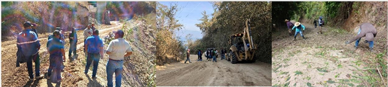
MANTENIMIENTO DE CAMINO RUTA AGUA ESCONDIDA - CABECERA MUNICIPAL
