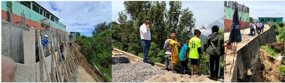
CONSTRUCCIÓN MURO DE GAVIONES CASERÍO SAN JOSÉ XIQUINABAJ
