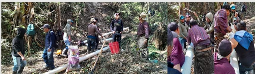
REPARACIÓN DE TUBERÍA CABECERA MUNICIPAL
