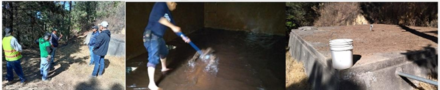
LIMPIEZA Y DESINFECCIÓN DE TANQUES DE AGUA EN CABECERA MUNICIPAL Y ÁREA RURAL
