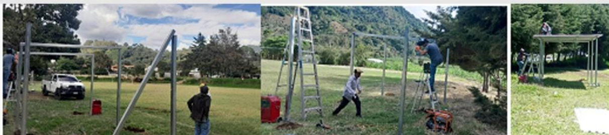
COLOCACIÓN DE GALERAS EN EL CAMPO DE FÚTBOL DEL CANTÓN SAN GABRIEL
